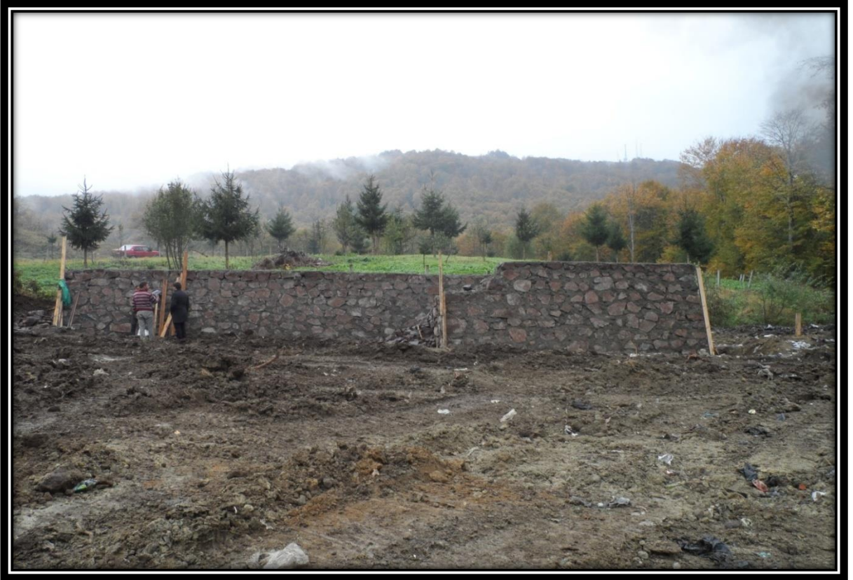
öp Depolama Alanı Taş Duvar İnşaatı
