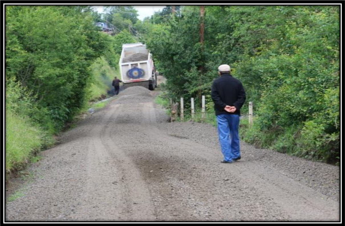
Çayıralan Mahallesi Stabilize (Filler) Yol Bakımı
