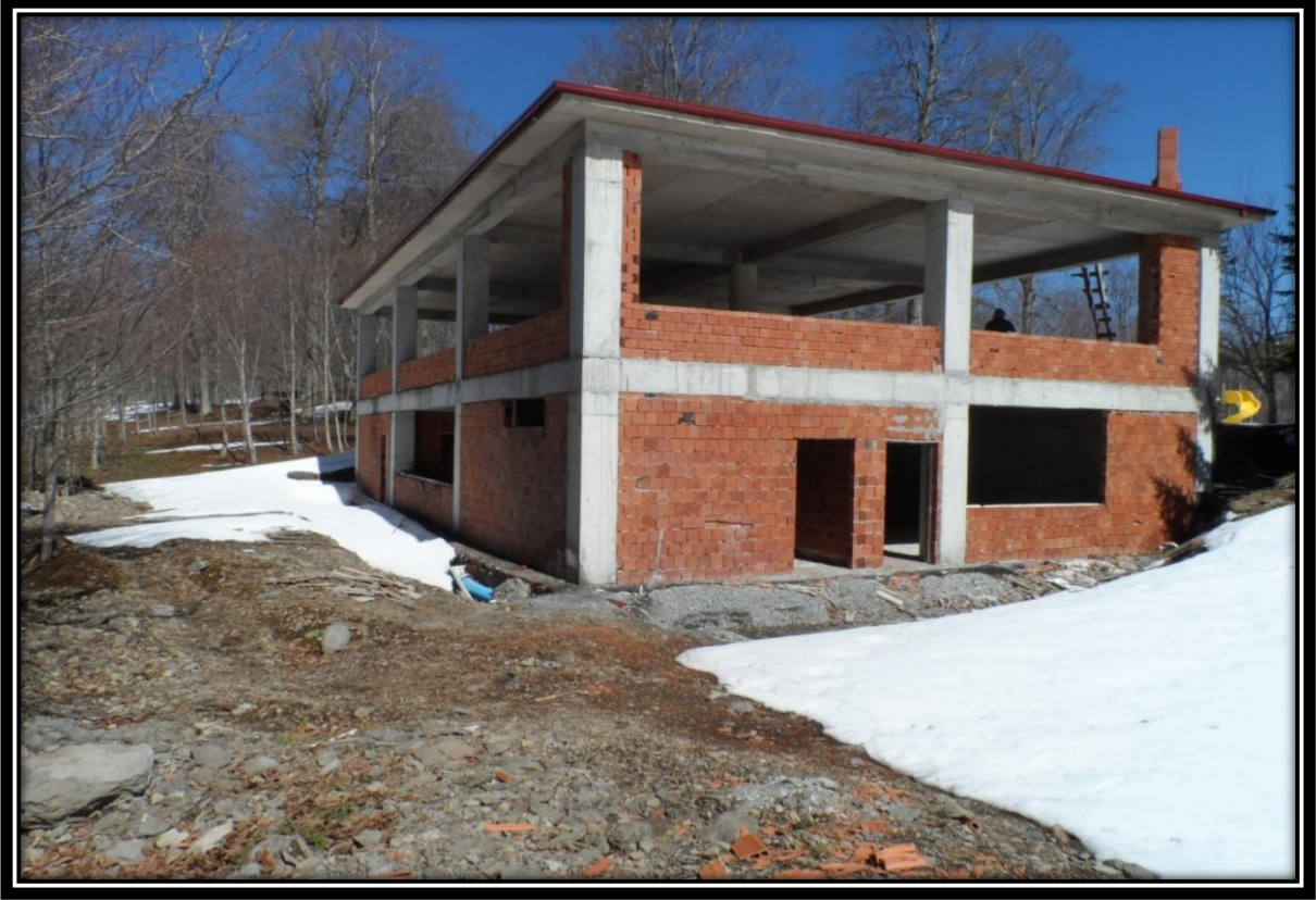
Kertil Mesire Alanı Lokanta Binası Temel Kazısı
