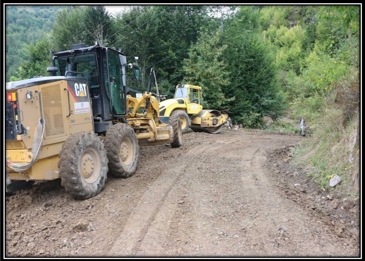
Kemikgeriř Mahallesi Yol alıřmaları
