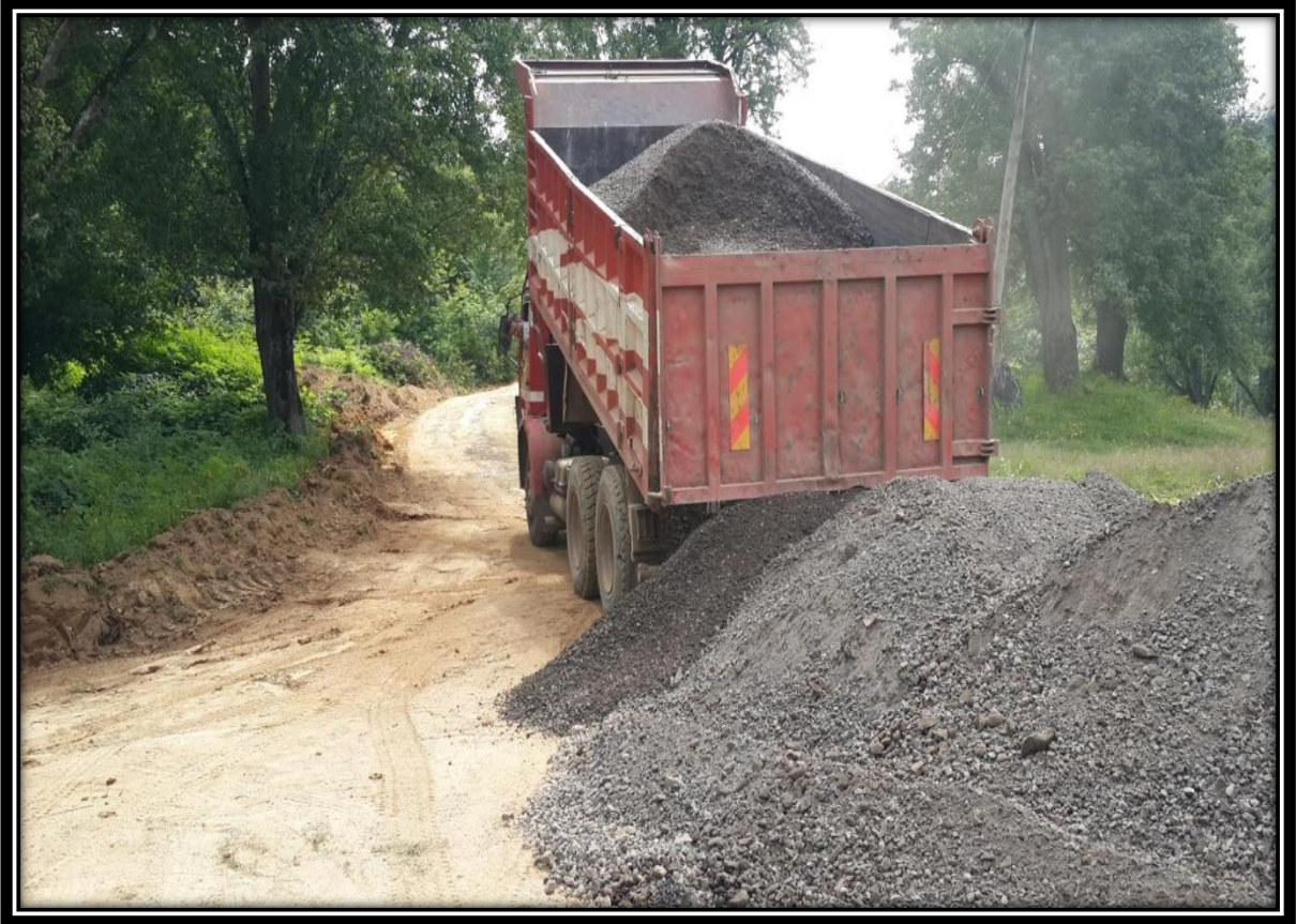
Salman Mahallesi Stabilize (Filler) Yol Bakımı
