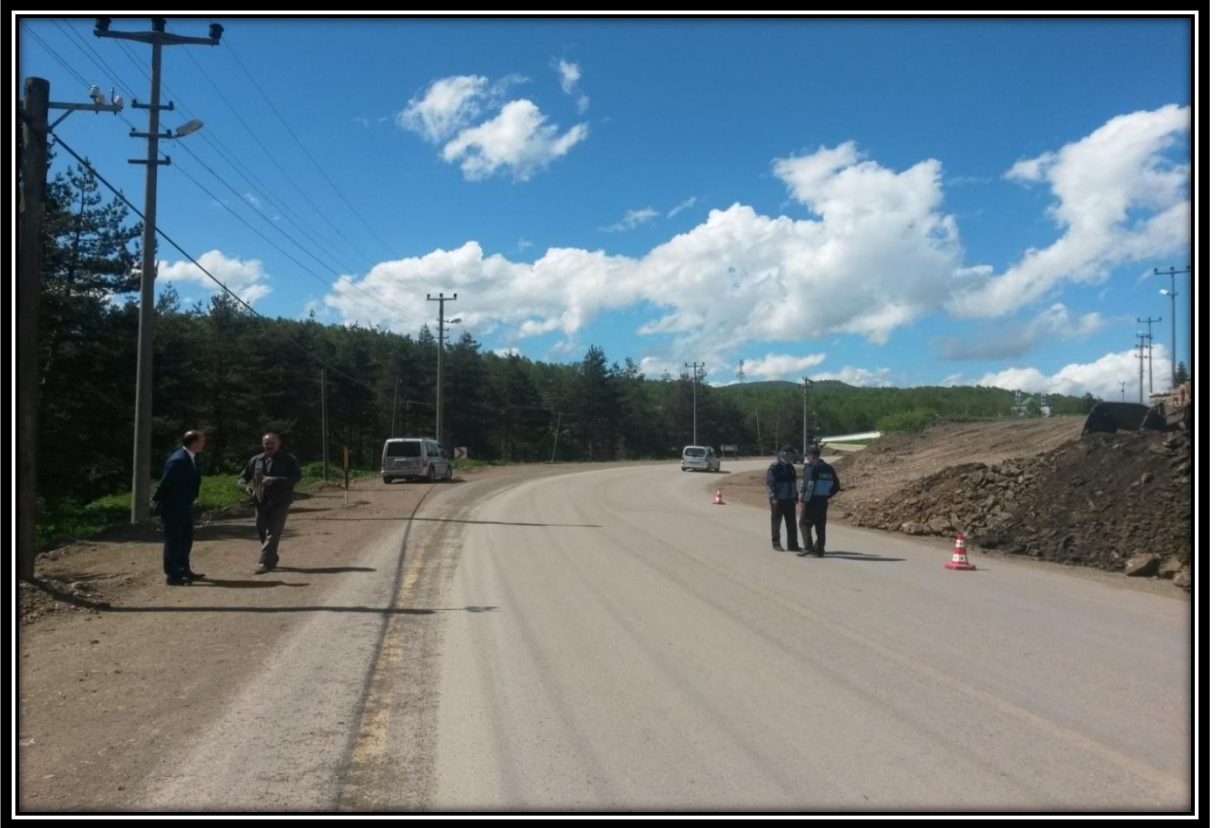
Yol Kenarı Çalışmaları esnasında yol Emniyeti sağlandı.
