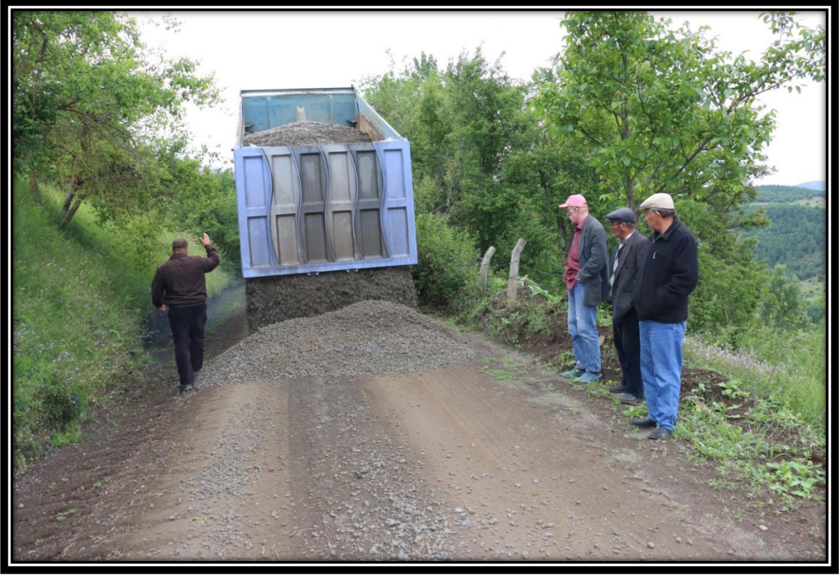
Yeşilgüneycik Mahallesi Stabilize (Filler) Yol Bakımı
