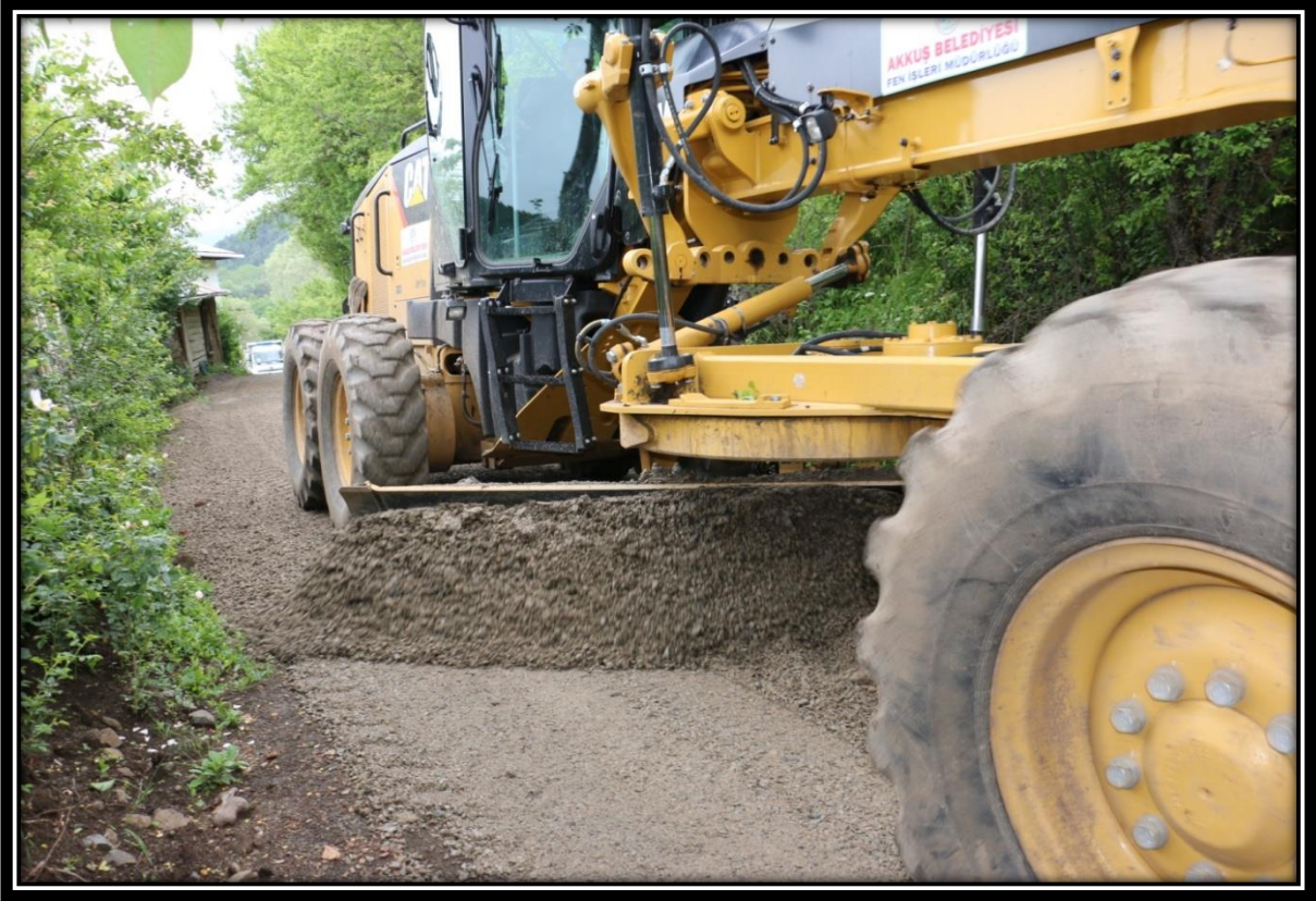
Yolbaşı Mahallesi Stabilize (Filler) Yol Bakımı
