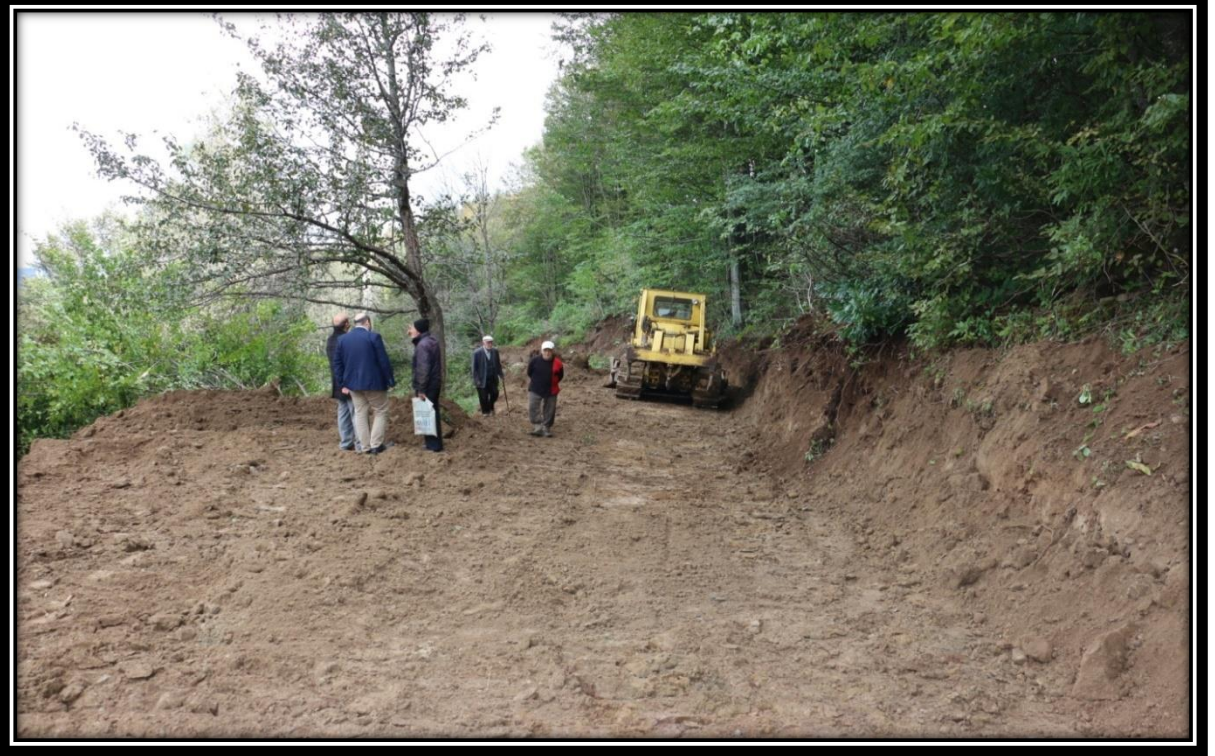
Esentepe (Eyüpoğlu) Mahallesi Yeni Yapılan Yol Çalışmaları
