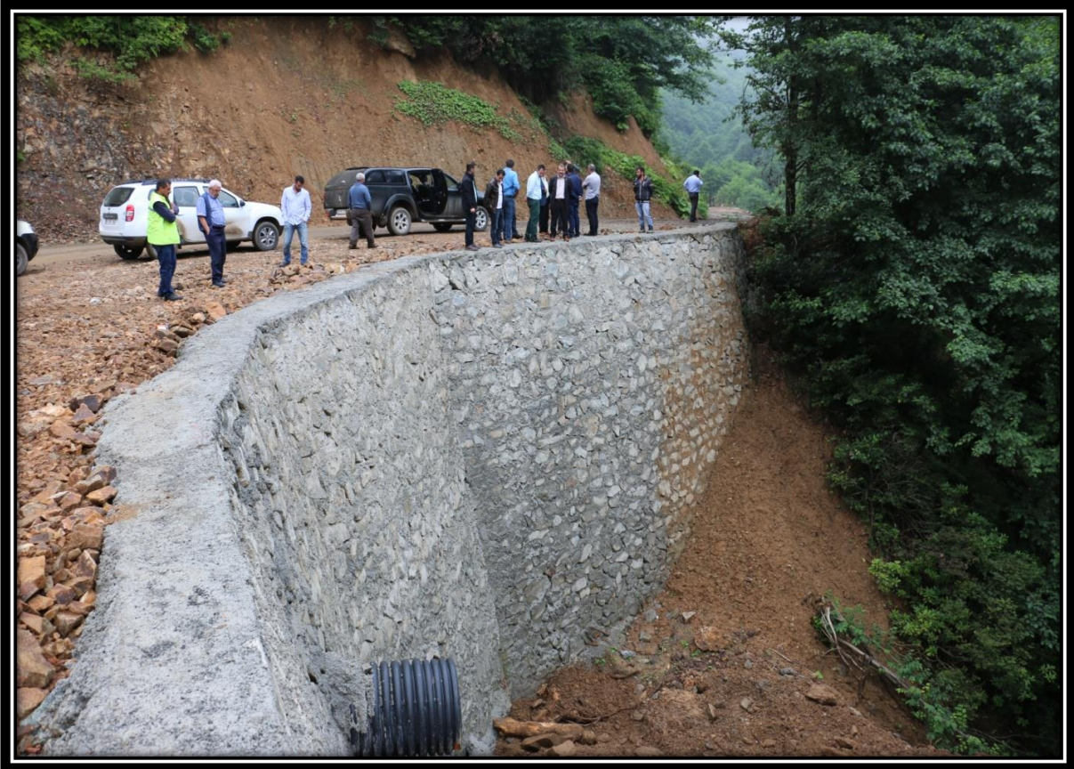
Kouvaz Mahalle Yolu İstinat Duvarı
