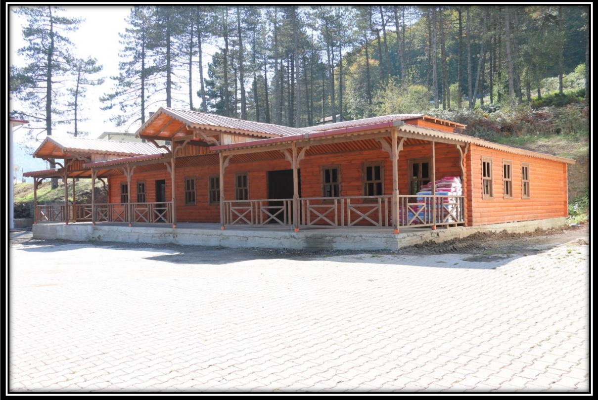
Akkuş Meslek Yüksek Okulu Kafeterya Binası
