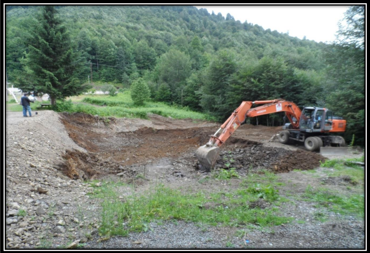
Kertil Mesire Alanı Lokanta Binası Temel Kazısı
