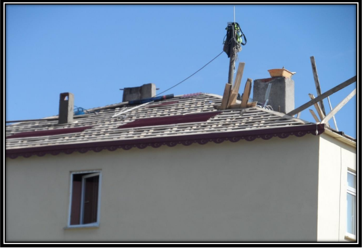
Kızılelma Mahallesi Lojman Binası Çatı Bakım
