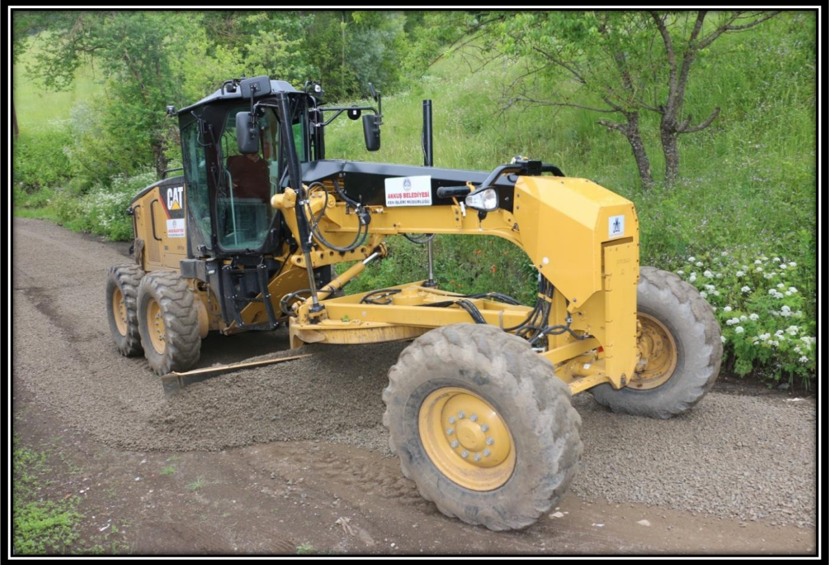
Düğencili Mahallesi Stabilize (Filler) Yol Bakımı
