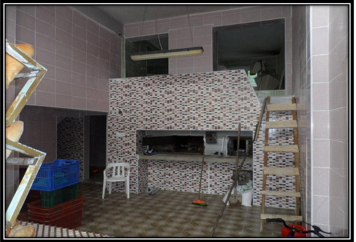
Akpınar Mahallesi Fırın Onarımı
