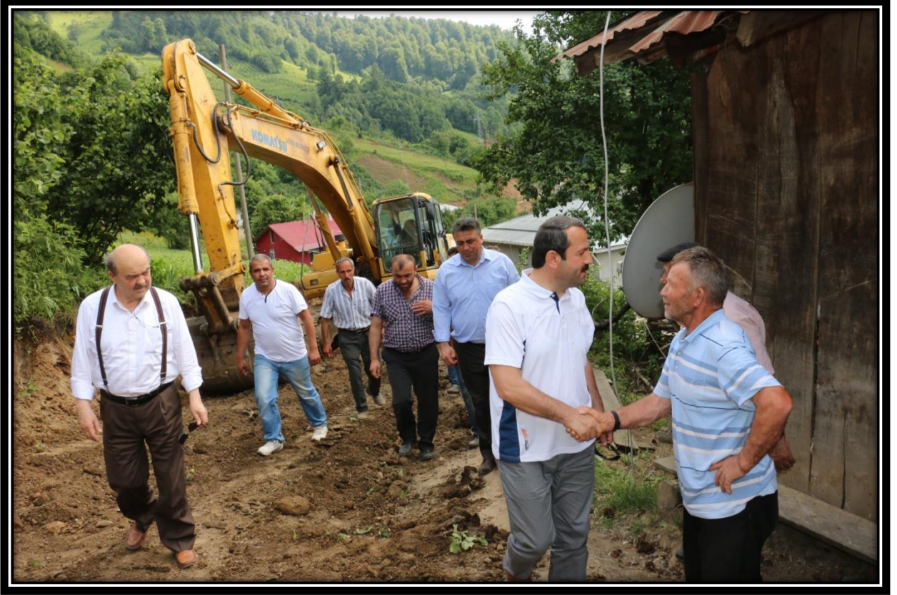
Salman (Gökler) Mahallesi Yeni Yol Yapımı
