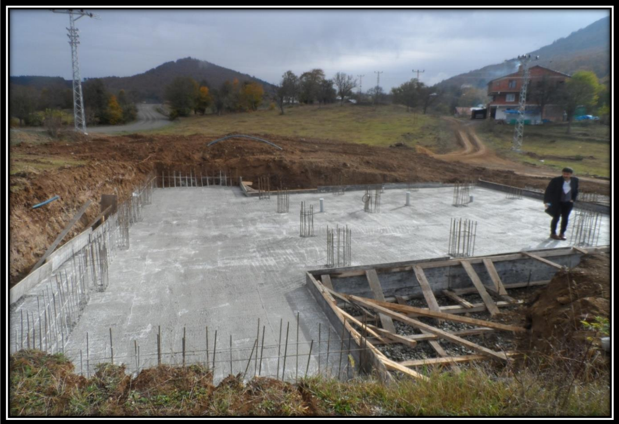
Çaldere Mahallesi Cüceyüzü Cami İnşaatı
