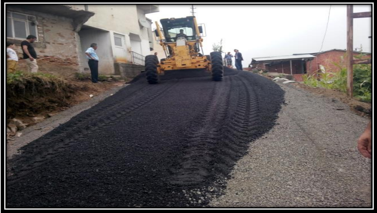
Salman Mahallesi İşletme Sokak Asfalt Yol Yapım Çalışması
