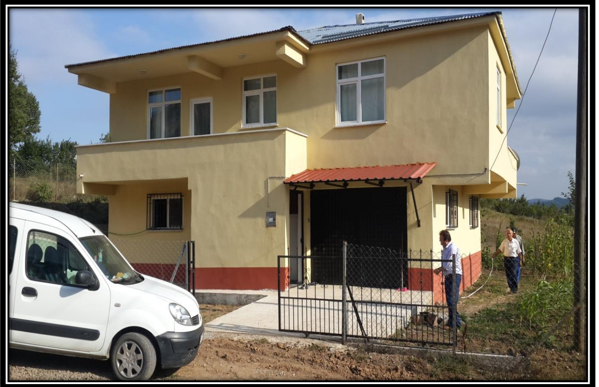
Kırsal yapıların denetimleri yapıldı ve kırsal yapı kullanma izin görüşleri verildi
