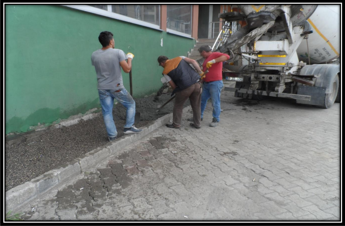
Yazlıkbelen Mahallesi Otogar ve Çevresinde Beton Kaldırım Yapımı
