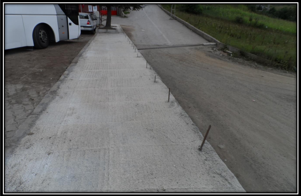
Otogar ve Çevresinde 350 M Beton Yol, Kaldırım ve Korkuluk Demiri Yapımı
