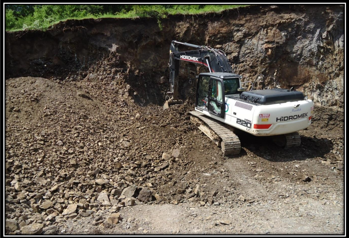
Yol Bakım Onarım İşeri için Ariyet Malzemesinin Ocakta Hazırlanması
