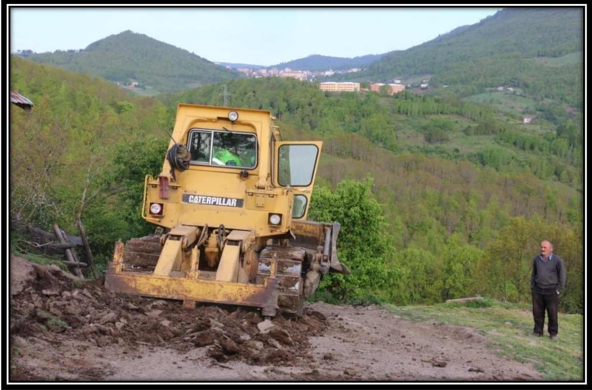
Çaldere (Serçek) Mahallesi Yeni Yol Yapımı
