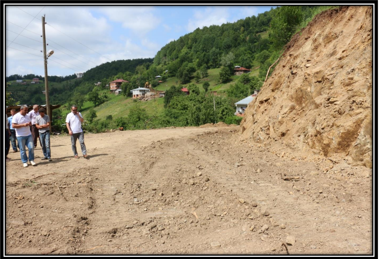
Salman (Gökler) Mahallesi Yeni Yapılan Yolda İnceleme
