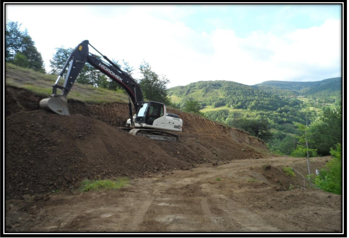
Seferli (Aliimamlar) Mahallesi Yol Geniřleme alıřması
