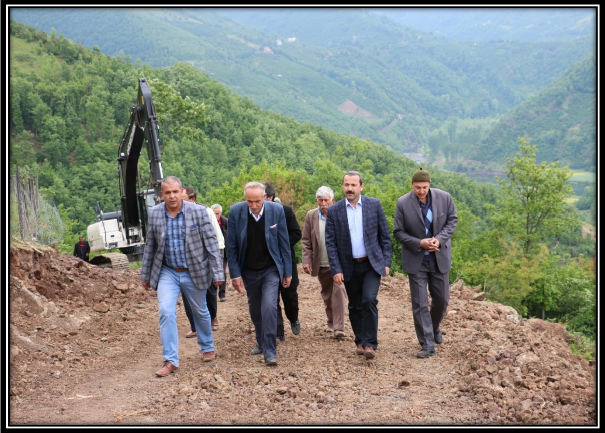
Çökek Mahallesi Yol Geniřleme alıřması
