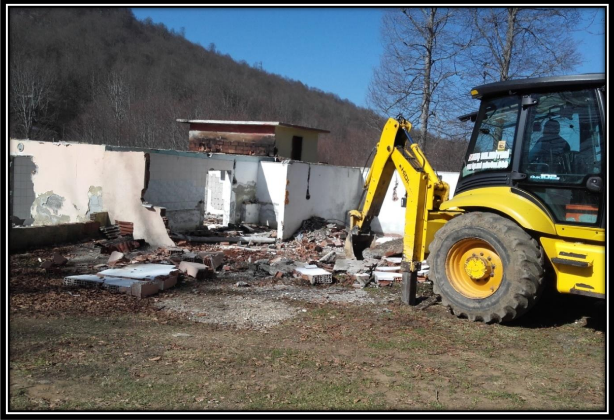
Kertil Mesire Alanı Eski Binaların Yıkımı
