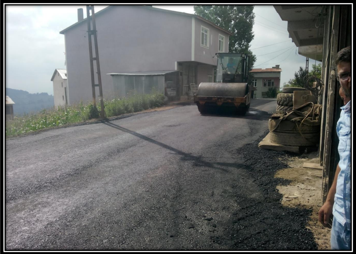
Salman Mahallesi Pazar Sokak Asfalt Yol Yapım Çalışması
