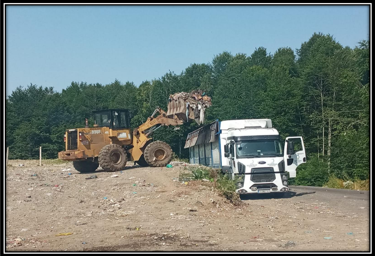
Toplanan çöpler Ordu Büyükşehir Belediyesine ait Ünye İlçesinde bulunan Mekanik Ayırıştırma Tesisine götürülmektedir.
