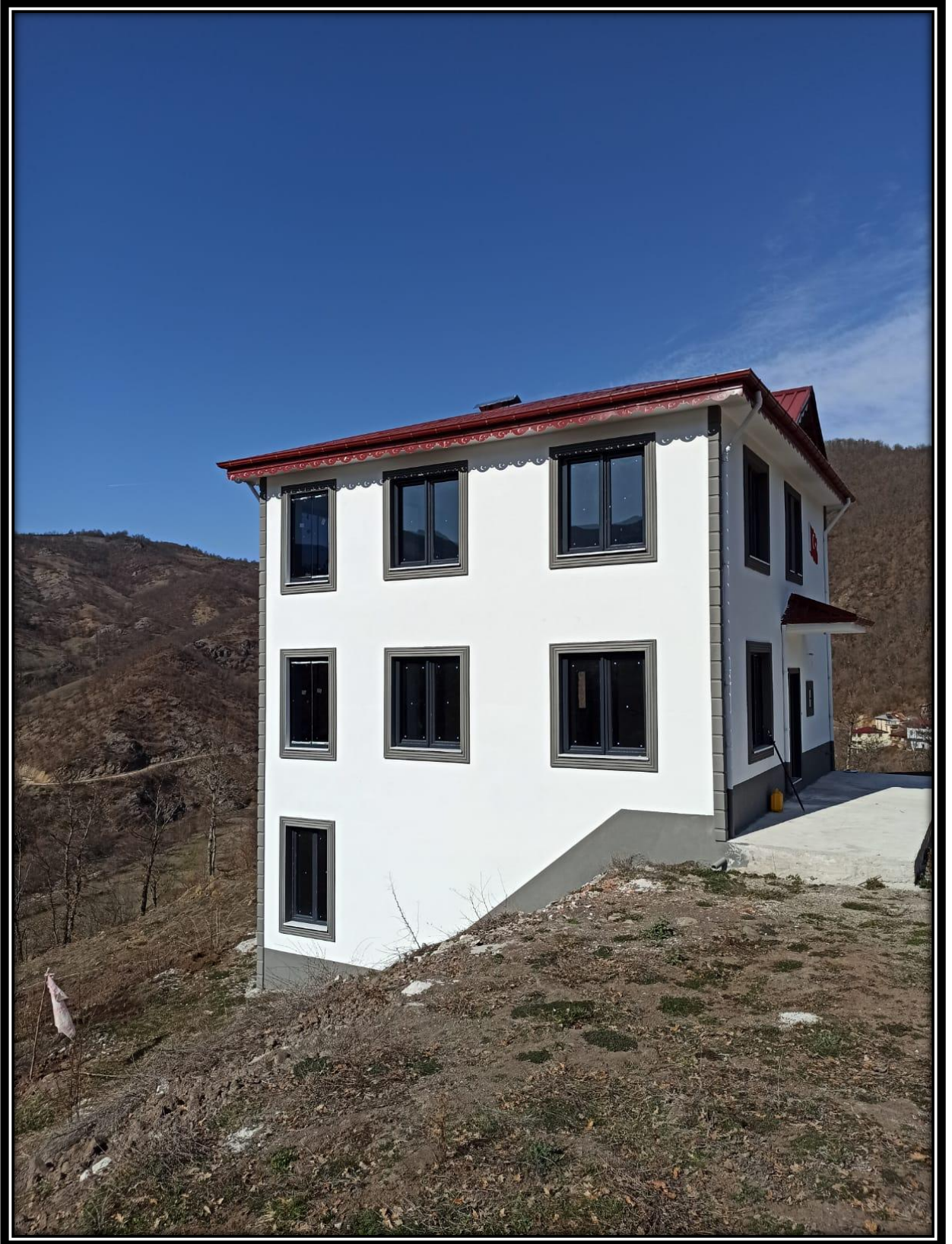
Kırsal alanlarda kontrolü yapılan bir bina
