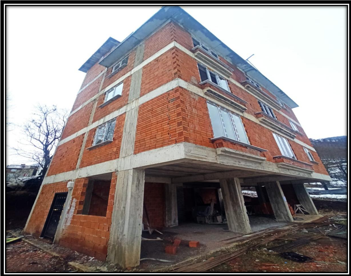
Yapı Denetimli bir İnşaat. (Yeni mah.)
