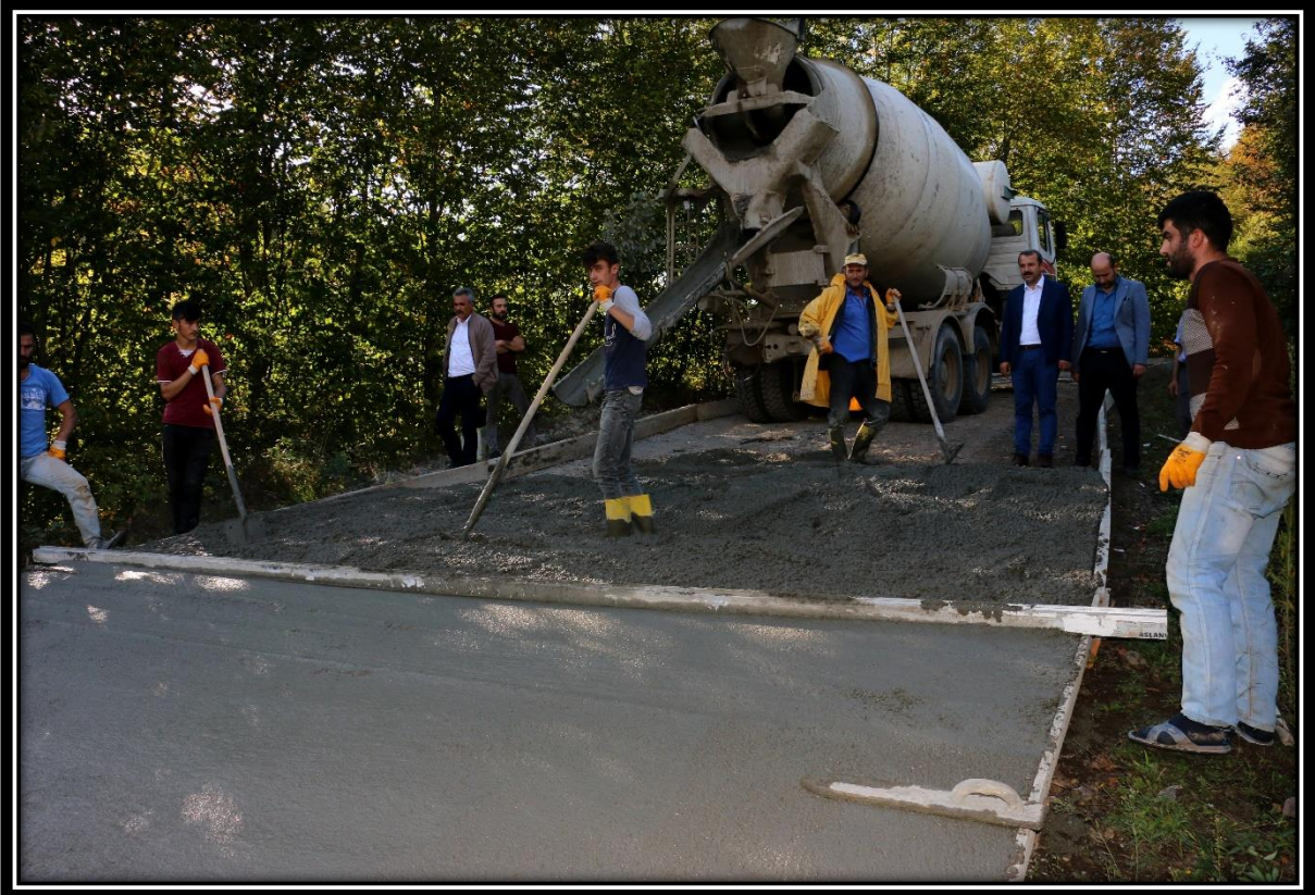
Akpınar Düzmeşe Mahallesi Beton Yol Yapımı.
