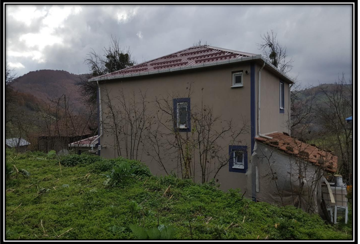
Kırsal yapıların denetimleri yapıldı ve kırsal yapı kullanma izin görüşleri verildi.
