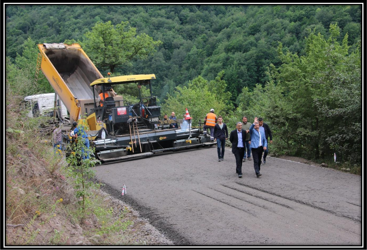
Akkuş-Salman Grup Yolu Sıcak Asfalt Çalışması.
