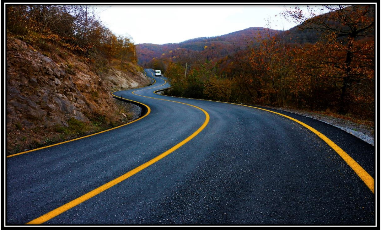
Akkuş-Salman Grup Yolu Sıcak Asfalt.
