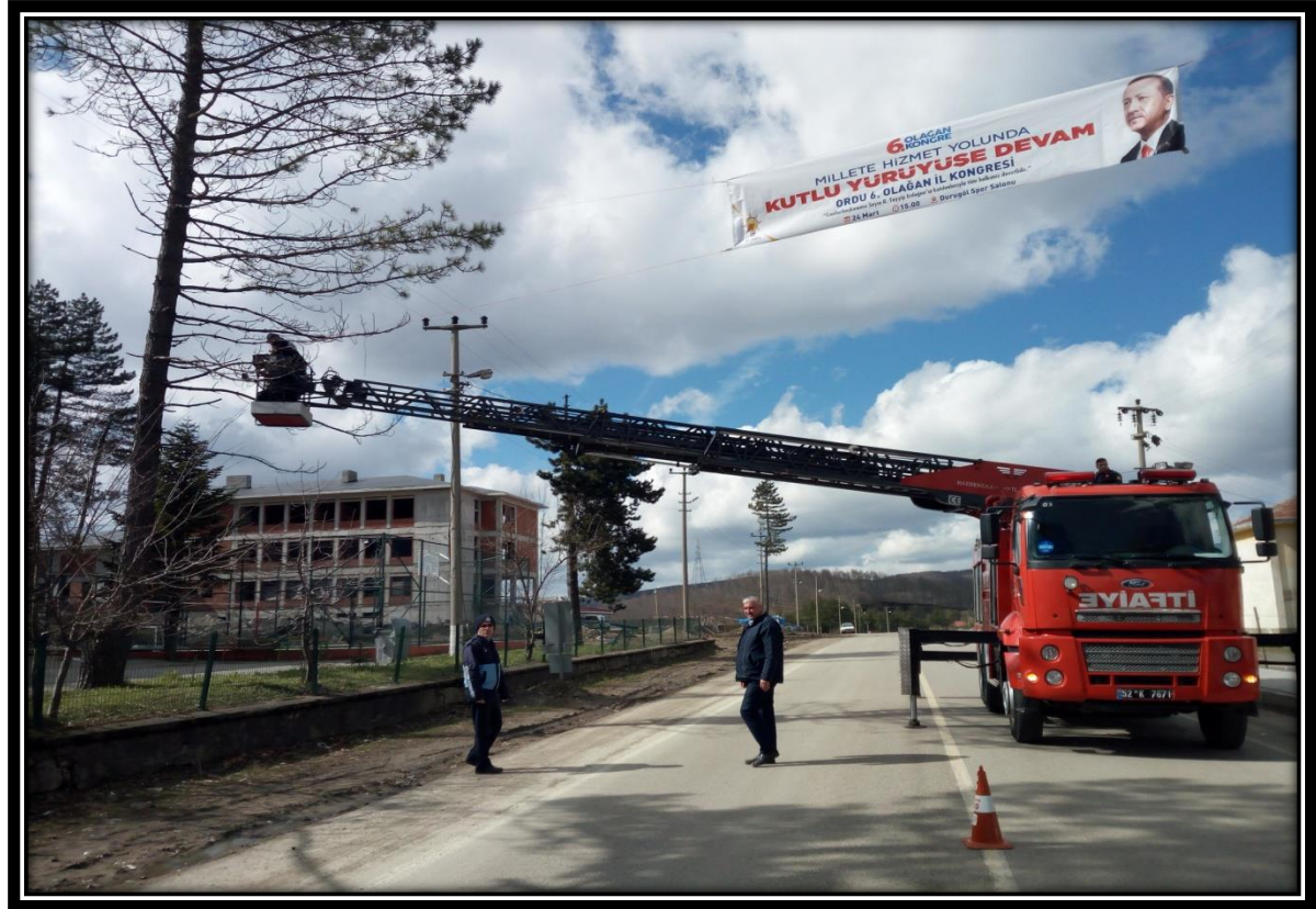
Yolda yapılan Çalışmalar esnasında yol Emniyeti sağlandı.
