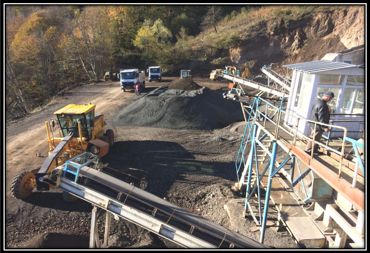
Kırma-Eleme Tesisi Alt Yapı Malzemesi Nakliye İşlemi.
