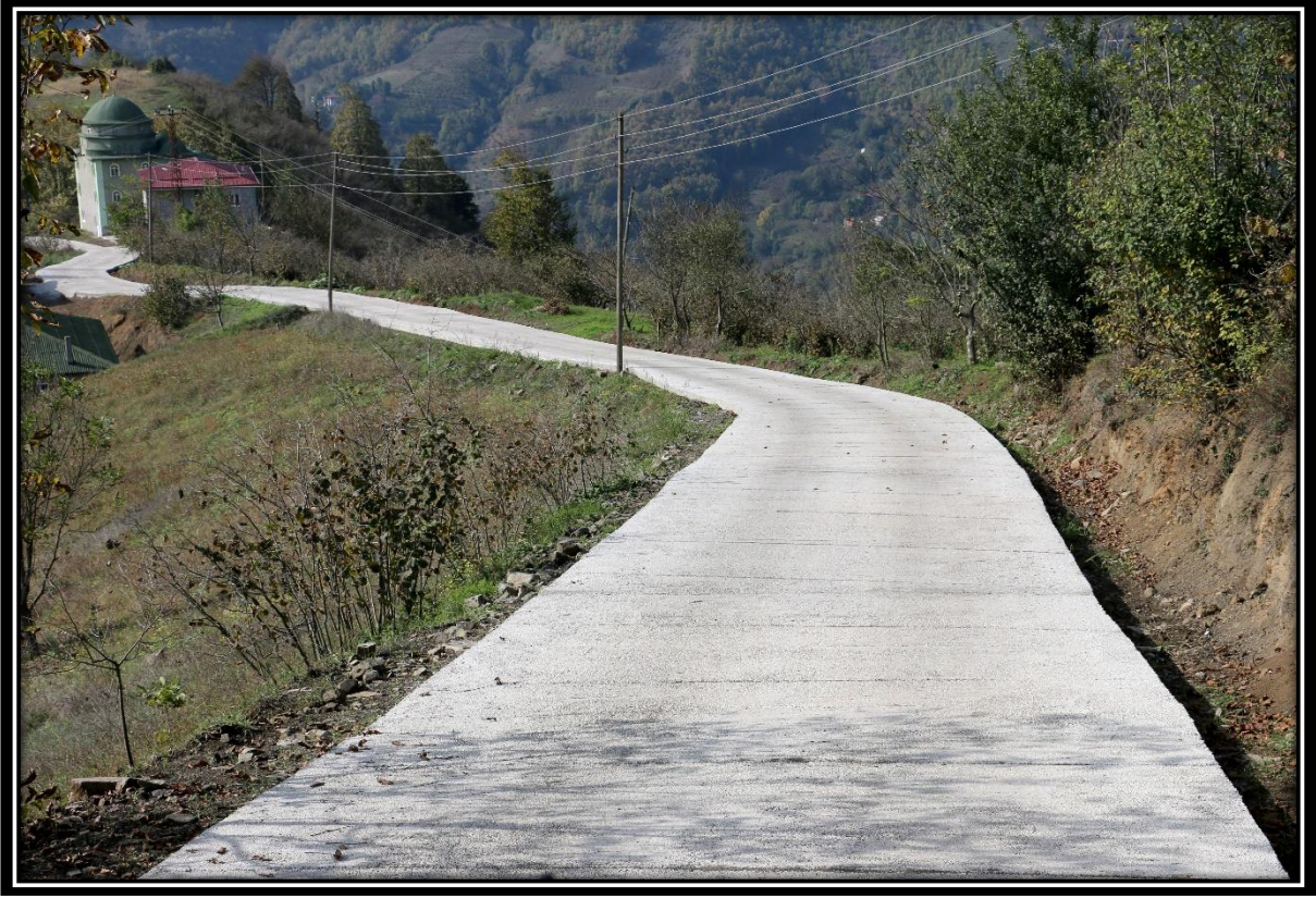
Kargı Mahallesi Beton Yol Yapımı.
