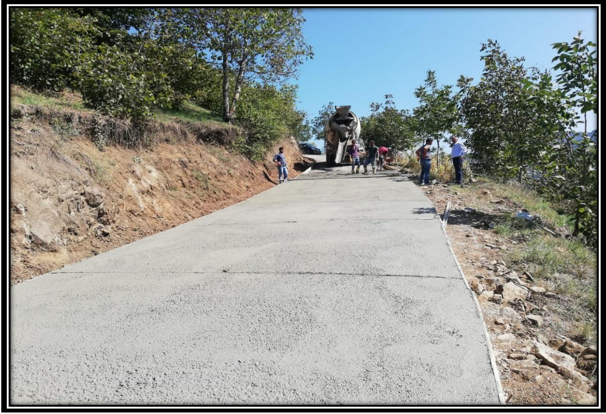
Akpınar Mahallesi Beton Yol Yapımı.
