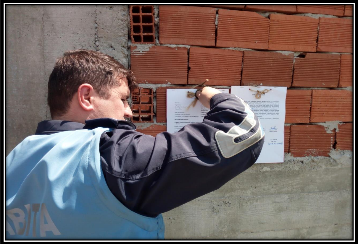
Kaçak Yapılan Yapılar Mühürlendi.
