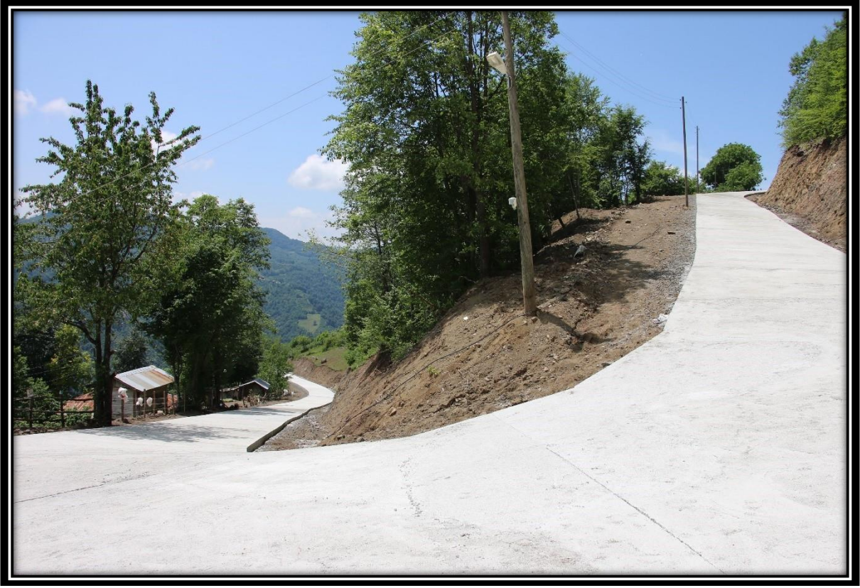
Salman Yokuşköy Beton Yol Yapımı.
