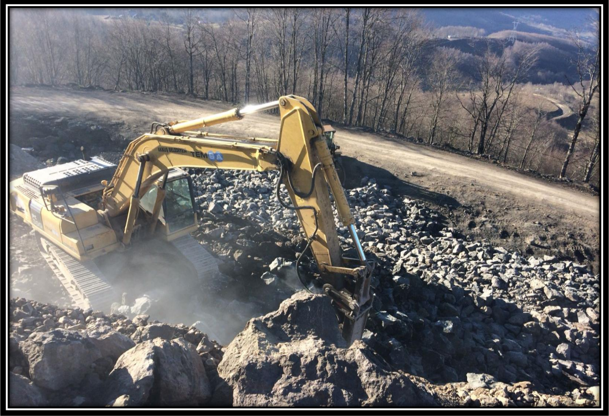
Maden Sahasında Kırıcı İle Konkasör Tesisine Malzeme Hazırlama.
