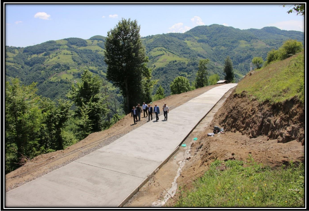
Salman Yokuşköy Mahallesi Beton Yol Yapımı.
