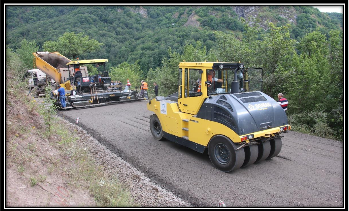
Akkuş-Salman Grup Yolu Sıcak Asfalt Çalışması.
