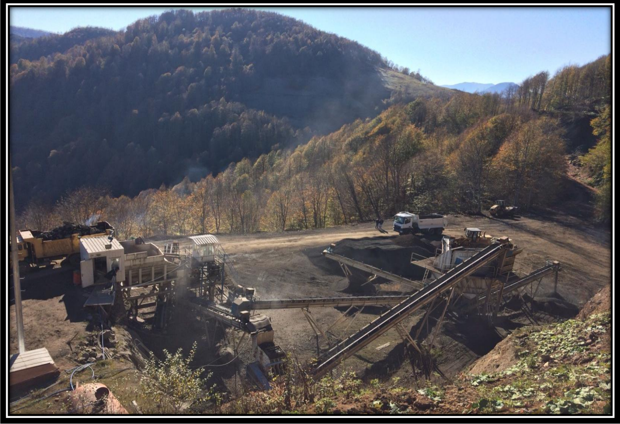
Kırma-Eleme Tesisi Alt Yapı Malzemesi Üretimi.
