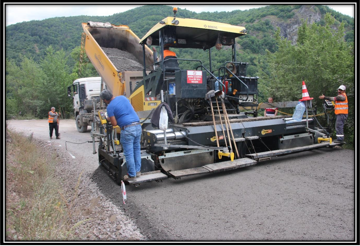
Akkuş-Salman Grup Yolu Finişer ile Sıcak Asfalt Çalışması.
