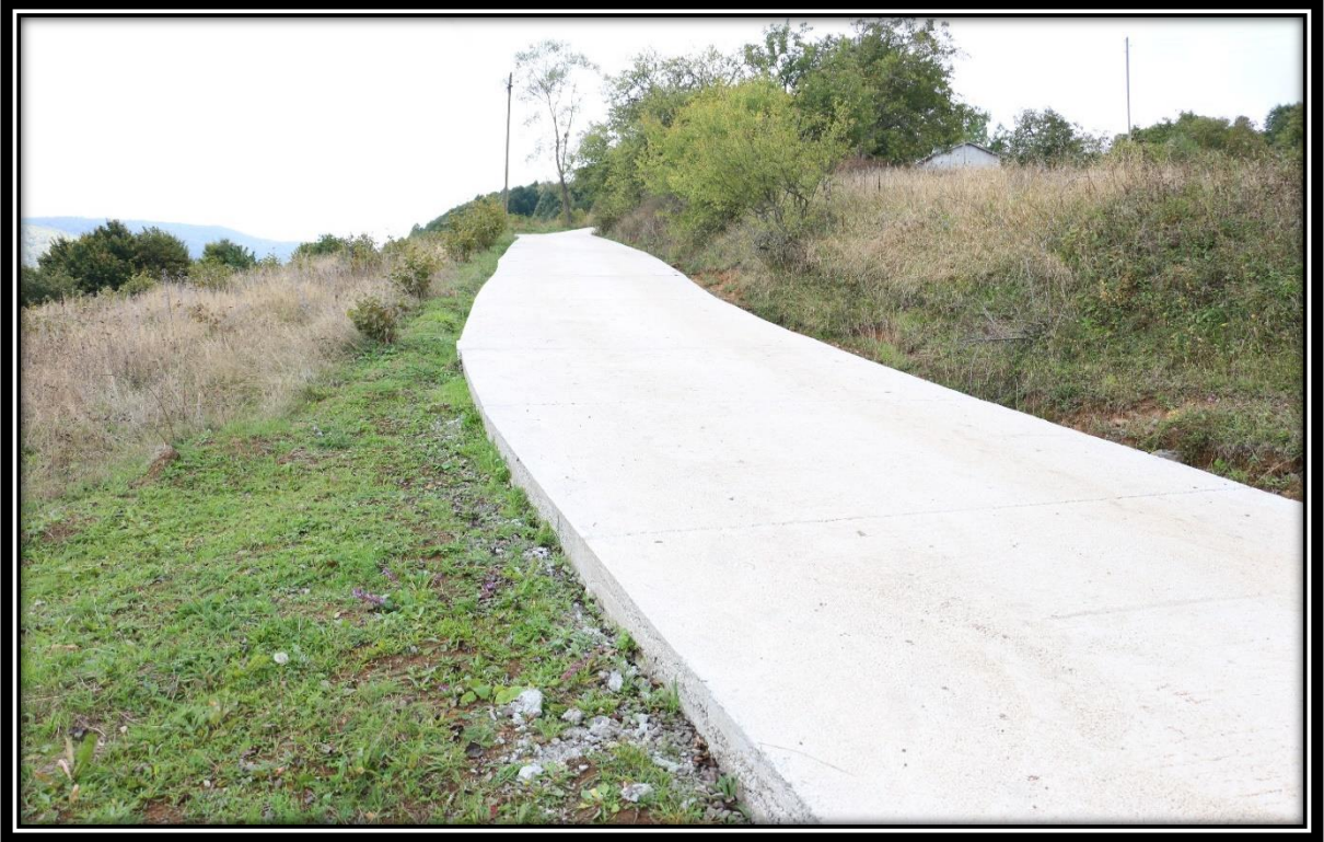
Tuzak Mahallesi Mahallesi Beton Yol Yapımı.
