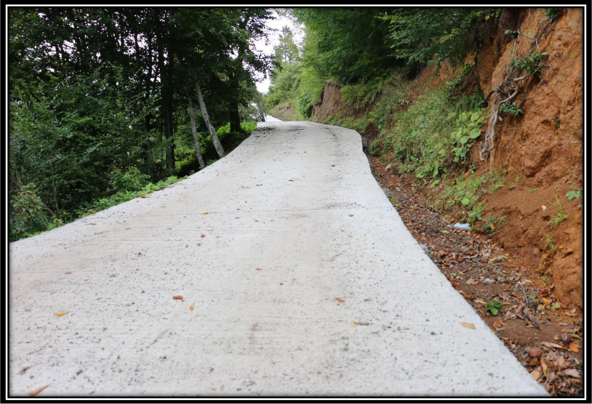
Seferli İsketi Mahallesi Beton Yol Yapımı.
